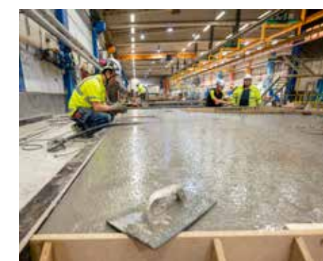
Hälften av all cement som används i vanlig betong har bytts ut mot spannmålsskal, en restprodukt från jordbruket.
