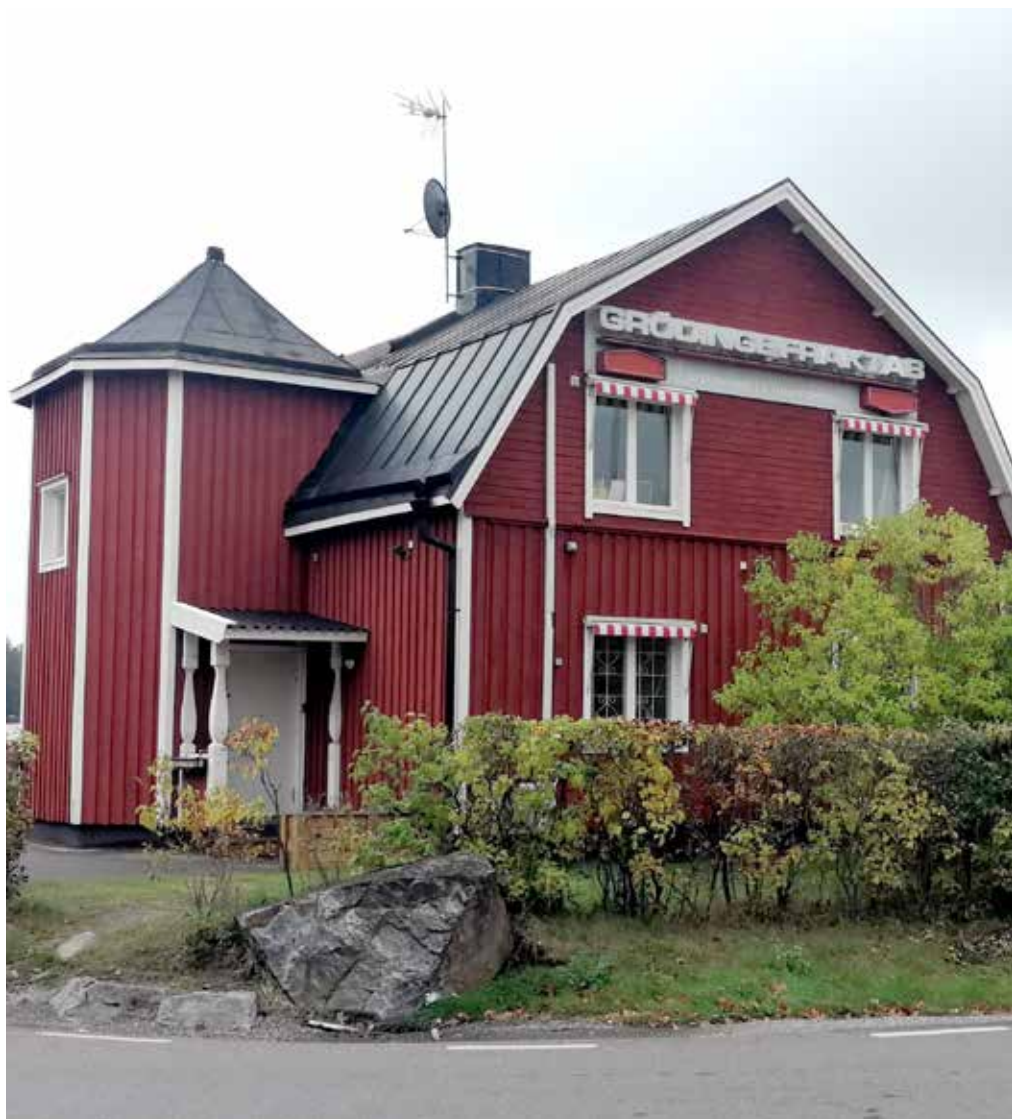
En del av kontorsbyggnaden.
